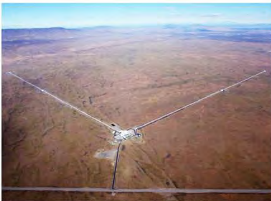
Brazos de luz en el detector LIGO en Hanford se extienden a través del terreno desértico del sureste de Washington. Cada brazo del detector en forma de L tiene 4.0 km de largo. (Crédito: LIGO)
