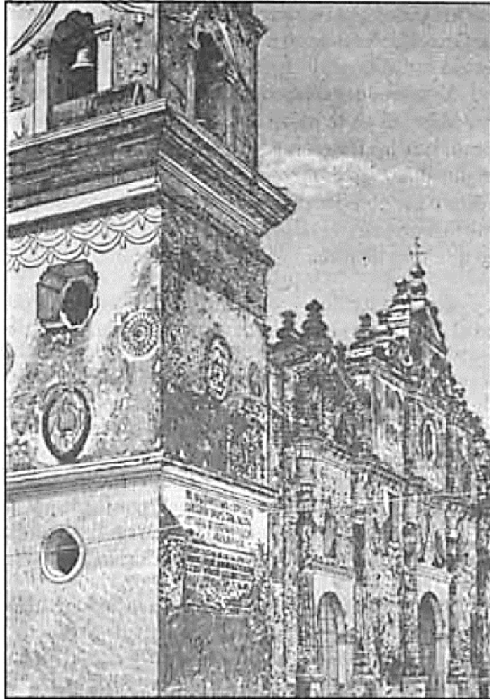
Figura 43.- Iglesia de La Merced, herencia de la arquitectura colonial en Granada. (Squier).
